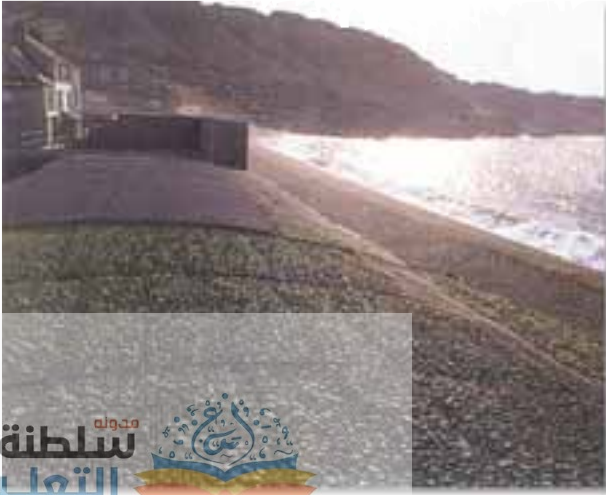
شكل (٣٣) فرشاة حجرية لحماية الشاطئ من التآكل بفعل الأمواج
